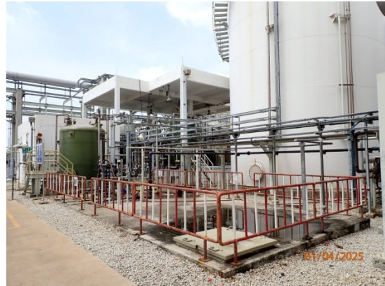
บ่อปรับสภาพกรด-ด่าง (pH Adjust Tank)
