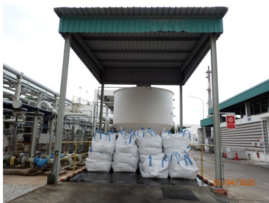
บริเวณพื้นที่กระบวนการผลิตที่อาจมีการปนเปื้อน รูปที่ 21 คันกั้นและการเทพื้นคอนกรีตบริเวณพื้นที่ที่อาจมีการปนเปื้อน
