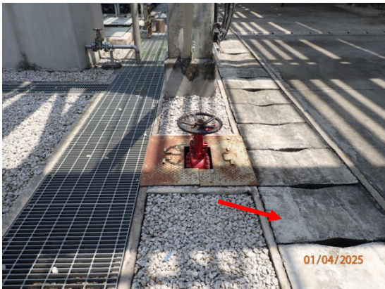
รูปที่ 15 รายละเอียดน้ำฝนที่แยกออกจากรางระบายน้ำของกระบวนการผลิต
