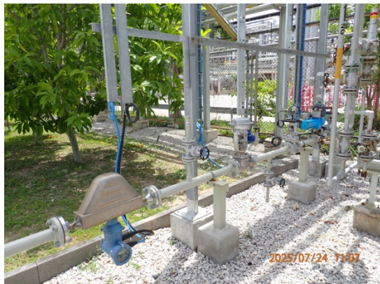
รูปที่ 62 Shut off valve บนเส้นท่อนำส่งก๊าซ เข้าระบบบำบัดอากาศ DFTO
