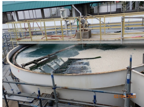
บ่อกำจัดตะกอนเบา (DAF Unit)
