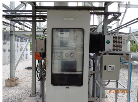
รูปที่ 3 ระบบ CEMs ของ DFTO หน่วยที่ 1 และหน่วยที่ 2
