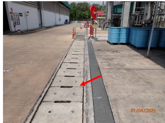
รูปที่ 15 รายละเอียดน้ำฝนที่แยกออกจากรางระบายน้ำของกระบวนการผลิต
