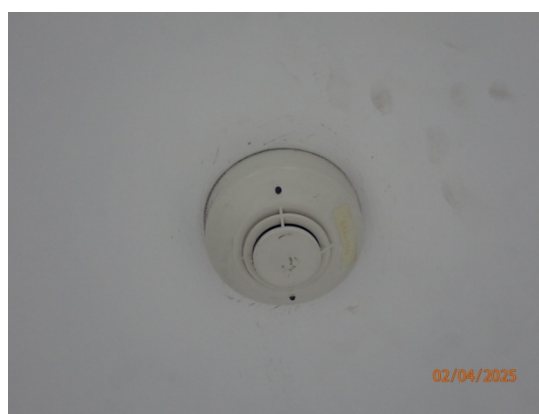
รูปที่ 30 Smoke Detector
