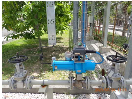
รูปที่ 63 Shut off valve บนเส้นท่อนำส่งก๊าซ เข้าระบบบำบัดอากาศ Thermal Oxidizer ชุดที่
