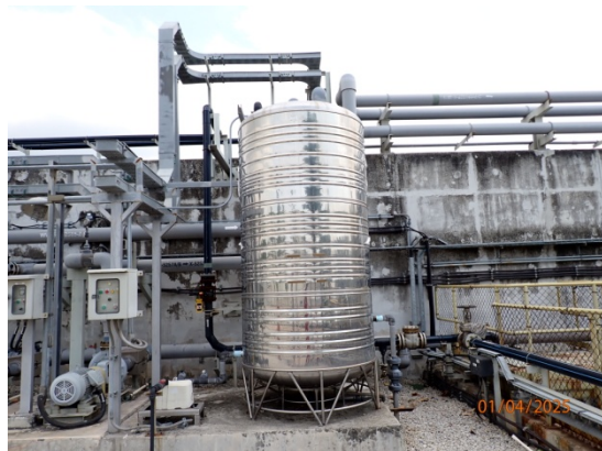
รูปที่ 19 การติดตั้งอุปกรณ์เพื่อนำน้ำที่บำบัดแล้วกลับมารดน้ำต้นไม้
