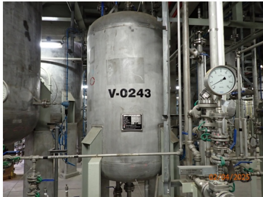
รูปที่ 59 ถังเก็บสารควบคุมน้ำหนักโมเลกุล 10
