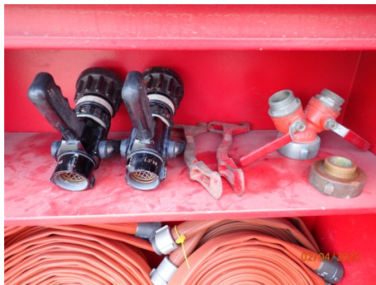
หัวฉีดน้ำดับเพลิง (Fire Water Nozzle / Monitor)
