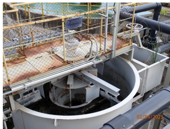
บ่อตกตะกอนแบบ High-rate DAF
